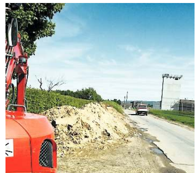
Galgenstraße: Der Erdaushub in der Galgenstraße sorgt für Engpässe bei den Lkw-Stellplätzen der Gemeinde.
